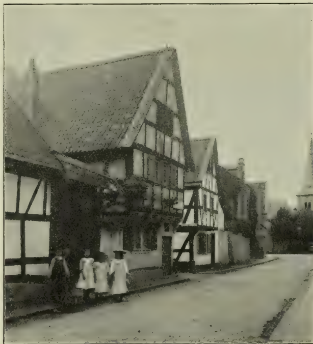
Fig. 93. Niederdollendorf. Fachwerkhaus vom Ende des 16. Jhs.
